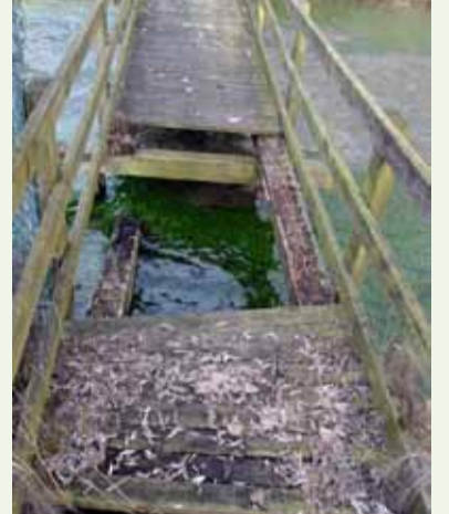
I vecchi ponti del Parco in corso di sostituzione
